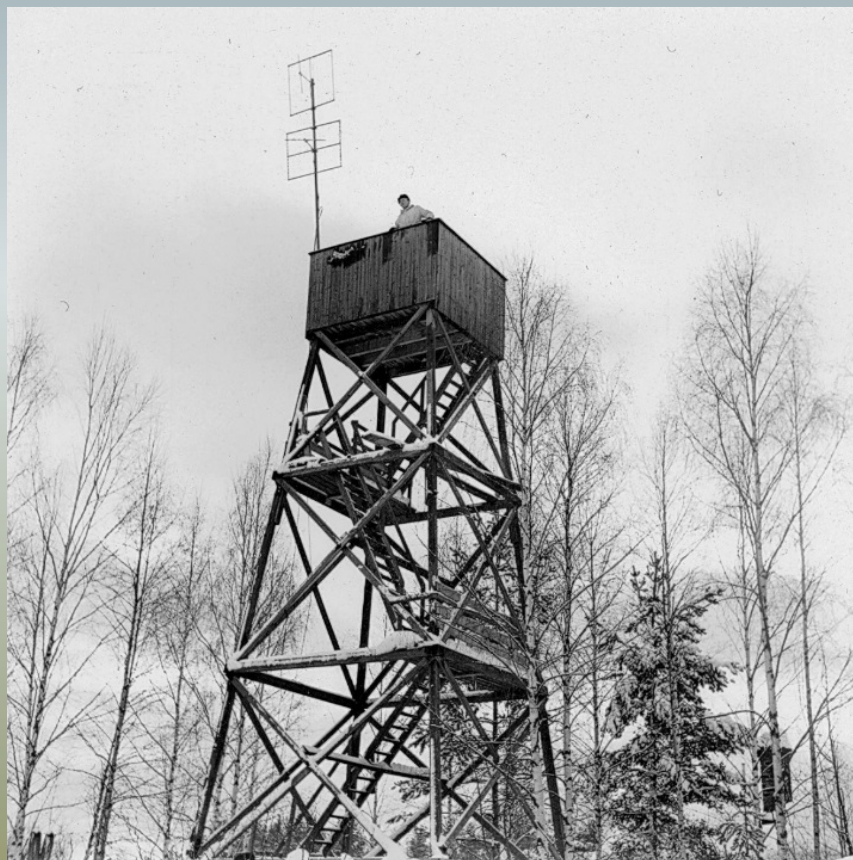
Äldre trä torn med antenner för RL-01
