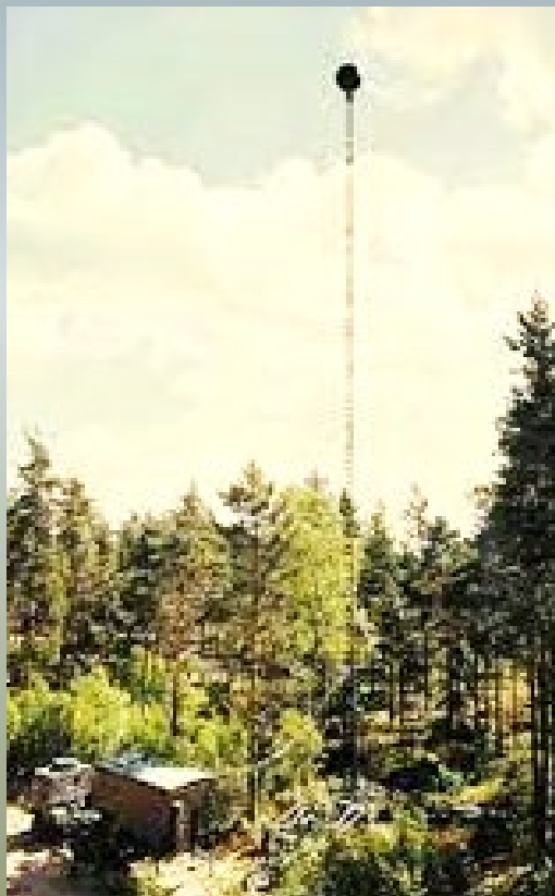
RL-47 med antenn i "kulradom"
