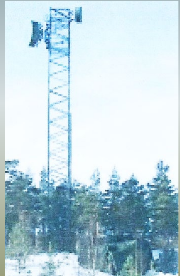
TS9000 nätanslutningspunkt (NAP) grupperad vid FTN-anläggning.
